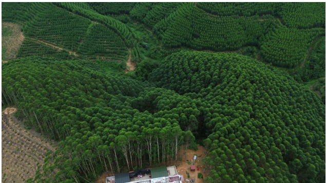
厂区南面现状
